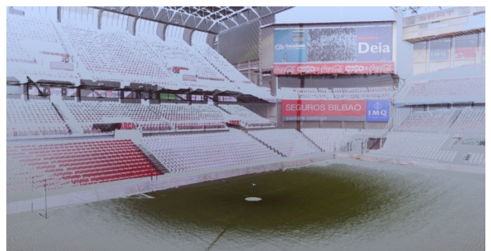
Figura 17. Digitalizado 3D con escáner láser del antiguo estadio de San Mamés del Athletic Club de Bilbao. Fuente: http://www.faro.com/
